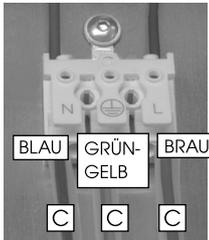
5. Versetzen Sie nun alle drei Kabel die in die Leuchte führen mit einem Silikonschlauch [C] aus dem mitgelieferten Montagekit. Die Silikonschläuche schützen die Kabel vor den hohen Temperaturen die in der Leuchte entstehen können.
