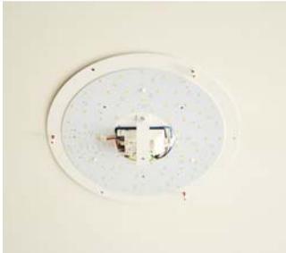
Montieren Sie nun das Leuchtenchassis mit für die jeweilige Decke/Wand geeigneten Dübeln und Schrauben. Achten Sie darauf, die LEDs nicht zu berühren um Schäden zu vermeiden.
