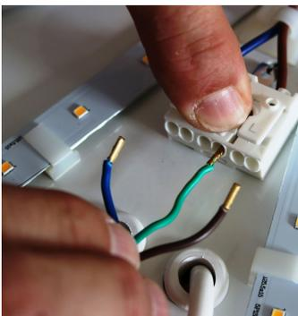
Die Leuchte enthält eine Steckklemme, durch Drücken der Taste, können die Leiter L, N und Schutzleiter eingesteckt werden, durch lösen der Taste werden die Leiter fixiert.
