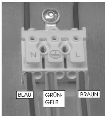
Links befindet sich der Nulleiter (N), blaues Kabel. In der Mitte befindet sich die Erdung, grün-gelbes Kabel. Rechts befindet sich die Phase (L), braunes oder schwarzes Kabel.
